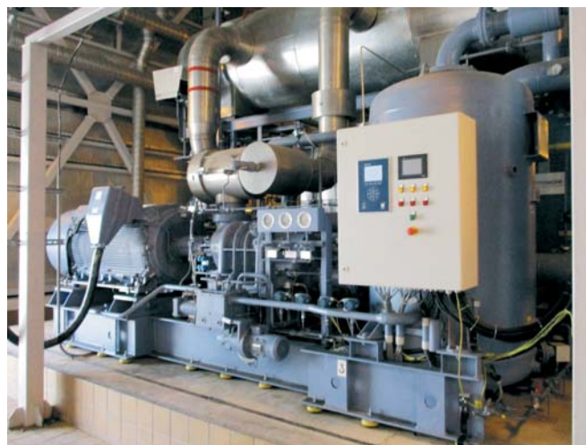
Рис. 2. Применение контроллера UNISAB III SABROE на чиллерной установке GEA GRASSO: а – исходный агрегат GEA GRASSO с контроллером SIEMENS; б – модернизированный агрегат GEA GRASSO с контроллером SABROE UNISAB III
