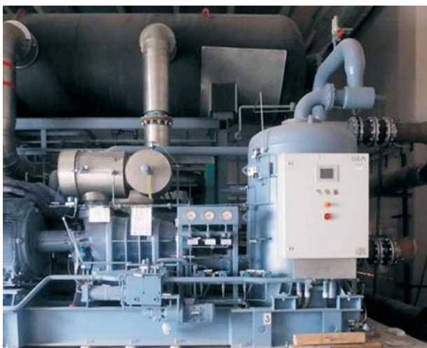
Рис. 2. Применение контроллера UNISAB III SABROE на чиллерной установке GEA GRASSO: а – исходный агрегат GEA GRASSO с контроллером SIEMENS; б – модернизированный агрегат GEA GRASSO с контроллером SABROE UNISAB III
